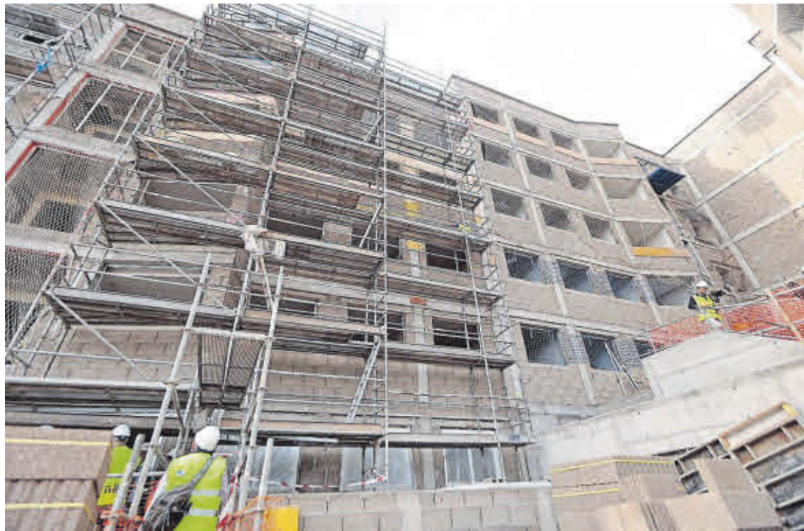
Viviendas en construcción
